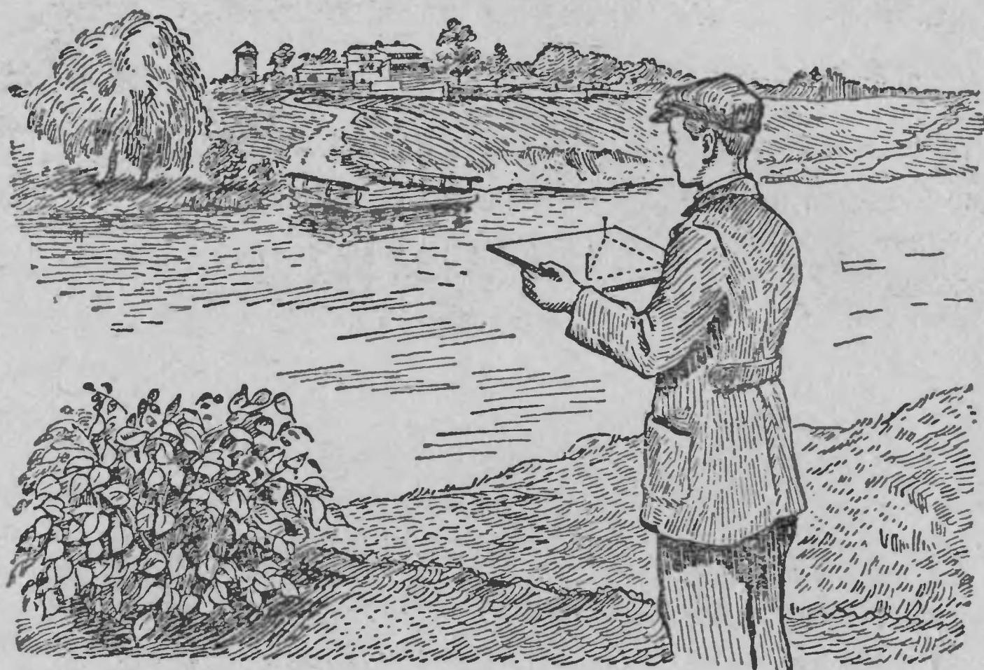
Рис. 25. Измерение ширины реки булавочным прибором.
