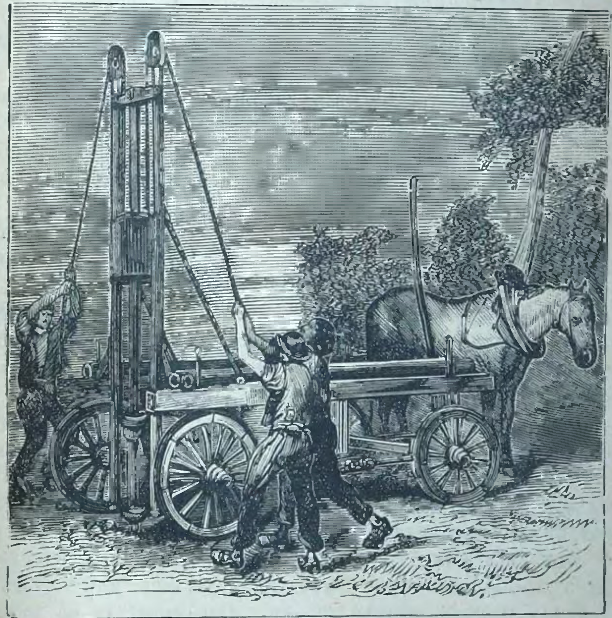
Рис. 234.—Вбиваніе трубокъ Нортонскаго колодца.
