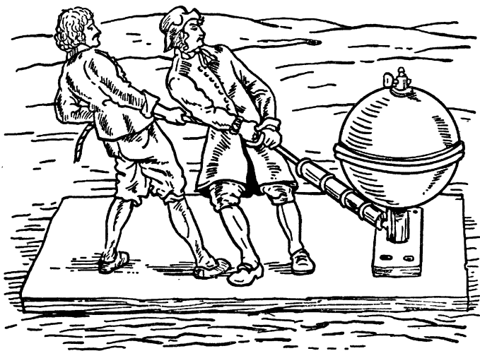
Рис. 75. Второй опыт Отто Герике над образованием безвоздушного пространства
